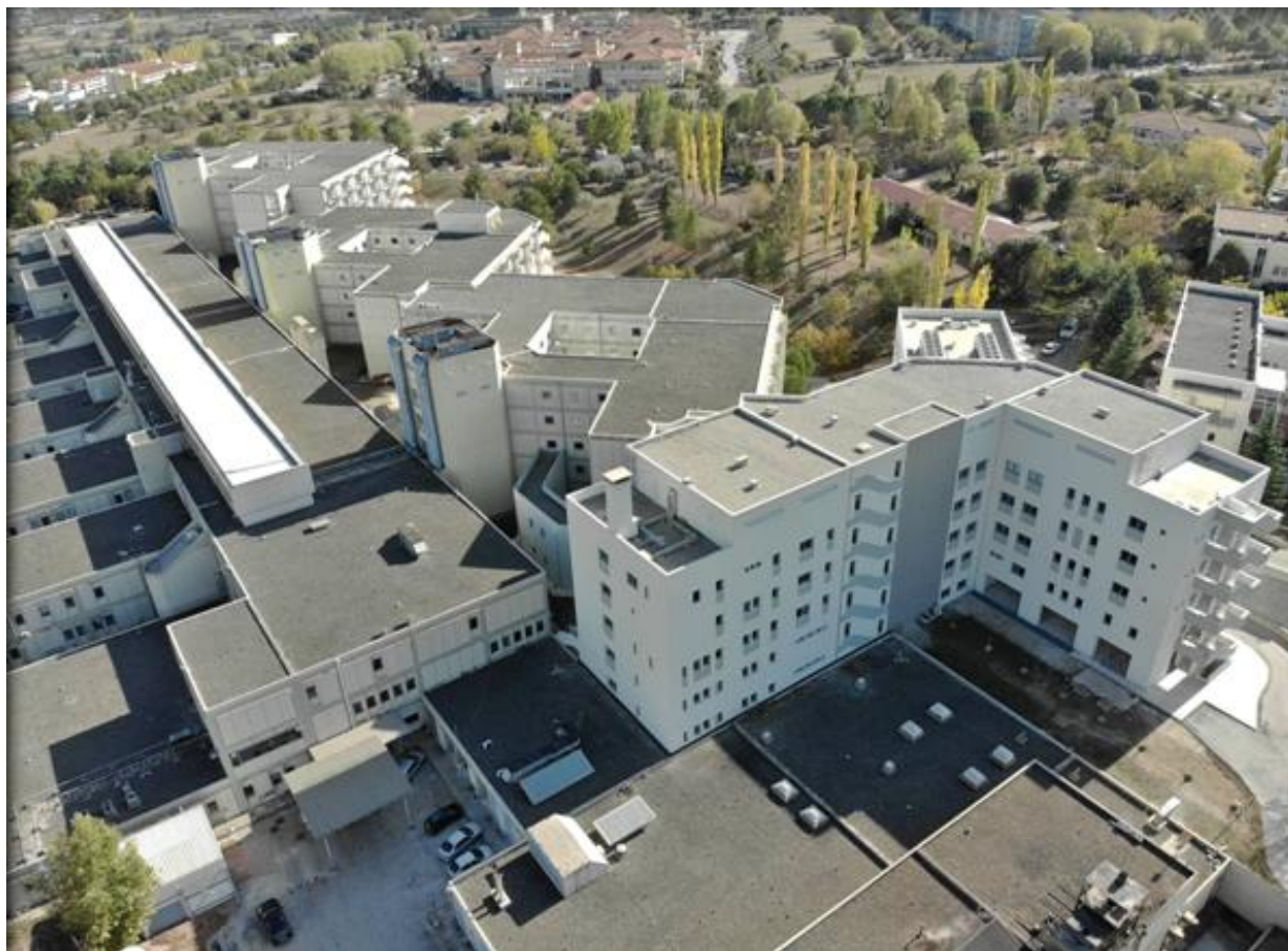
Νέο 5όροφο κτίριο (Δ' Ward)
