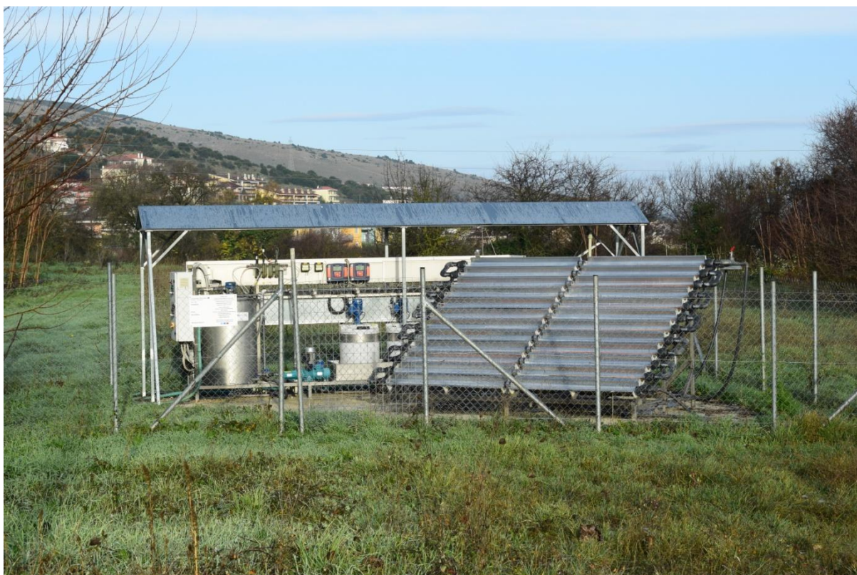
Σύστημα φωτοκαταλυτικής επεξεργασίας νοσοκομειακών υγρών αποβλήτων για την απομάκρυνση ανθεκτικών φαρμακευτικών ενώσεων
