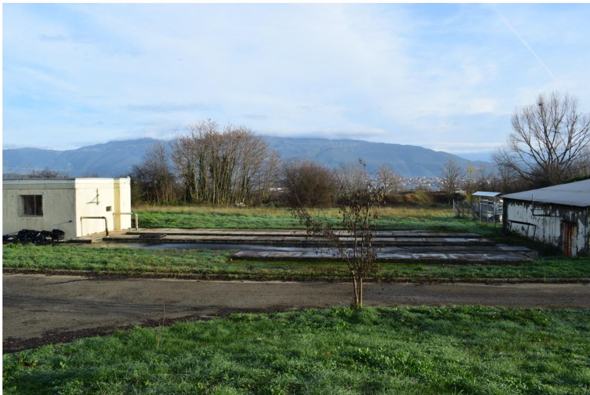
Εγκατάσταση Βιολογικού καθαρισμού λυμάτων Νοσοκομείου
