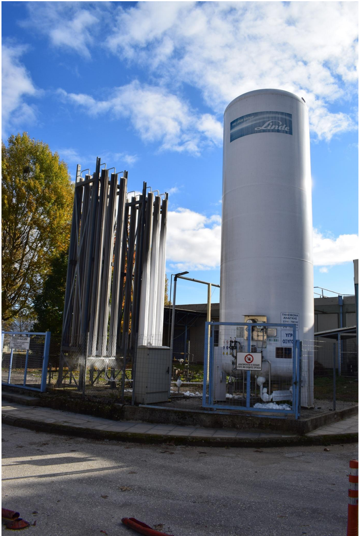
Εγκαταστάσεις υγρού Οξυγόνου για τροφοδότηση της κεντρικής παροχής
