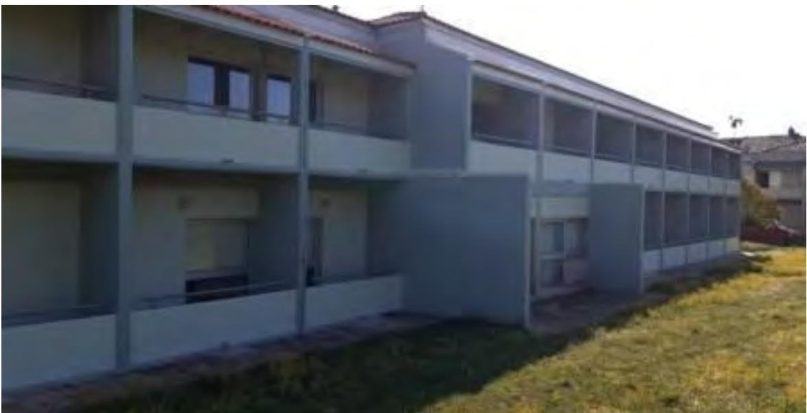
Το κτίριο παρουσίαζε έντονες φθορές με ρηγματωμένα και αποσαθρωμένα τμήματα και με εμφανή αποκάλυψη του οξειδωμένου οπλισμού στα δομικά στοιχεία του.
